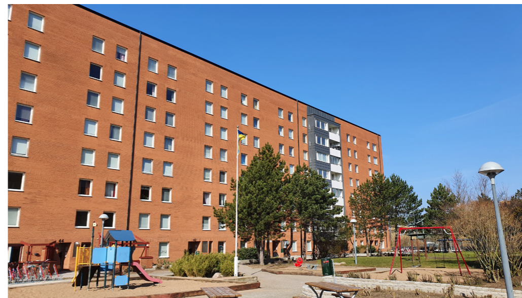
Bjälklag där det är svårt för träd att bli riktigt stora.
