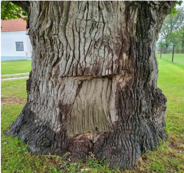
Figur 1. Den så kallade Avaken på Fårö som fyllts med sten, dränering och där betong använts som försegling. Foto: Johan Östberg.
